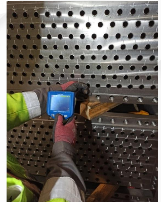
Осмотр внутренней поверхности трубы с помощью эндоскопа
