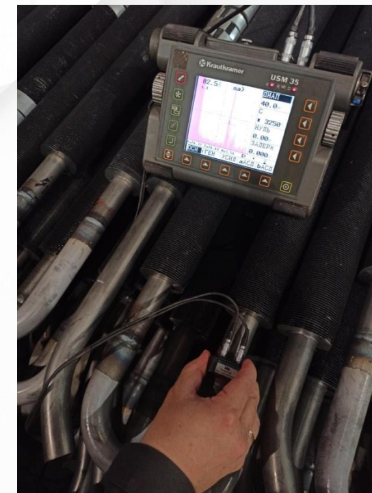
Проведение ультразвукового контроля сварных соединений змеевиков
