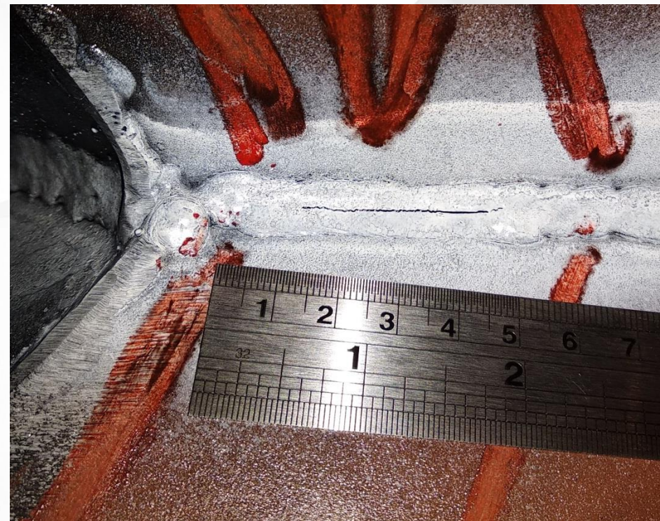
Линейная индикация в сварном шве (трещина)
